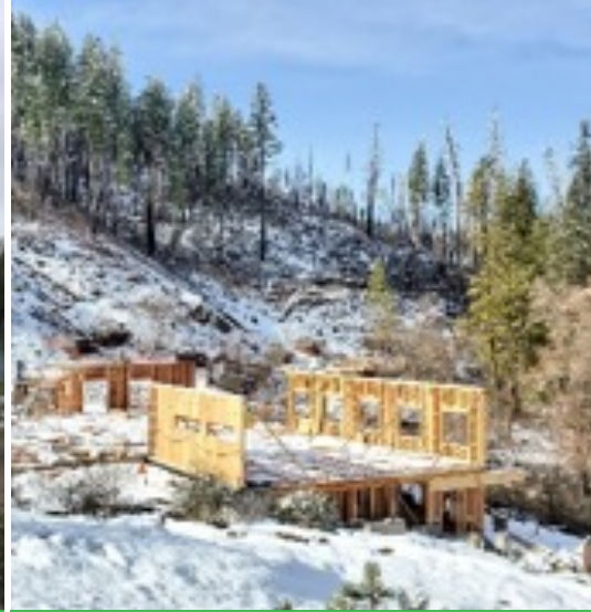
Berkeley Tuolumne Camp renovation
