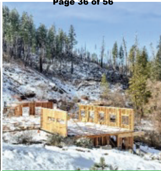
Berkeley Tuolumne Camp renovation
